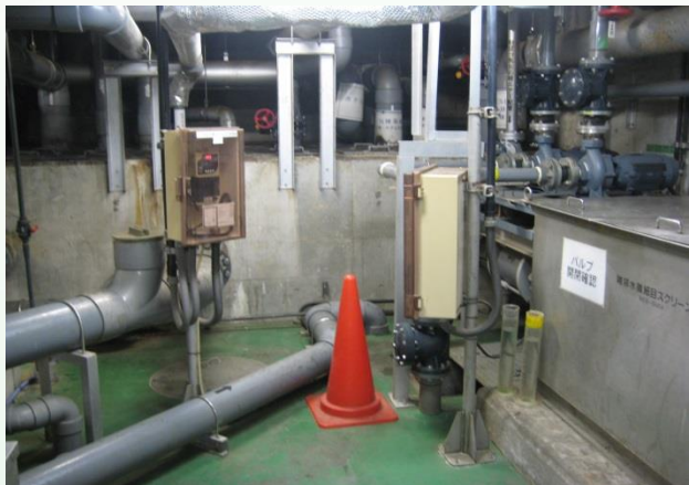
雑然とした機械室 これではメンテが大変
