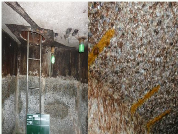
劣化が進んでいても 見過ごされているケースも
