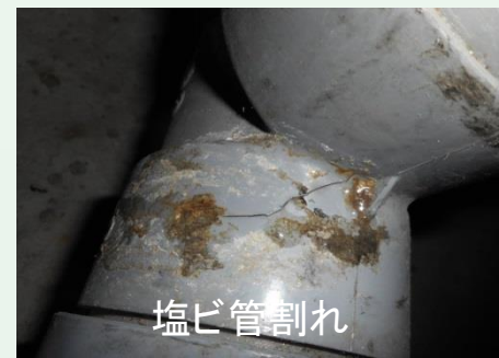
腐食による浮き、臭気漏洩
