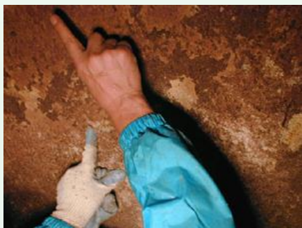
躯体劣化(骨材露出)
