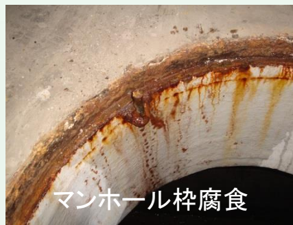
腐食による浮き、臭気漏洩
