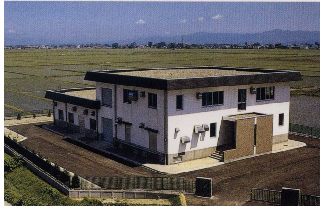
青森県柏村玉稻池区農業集落排水処理施設
