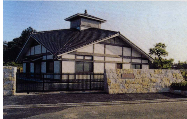
滋賀県愛東町百済寺地区農業集落排水処理施設
